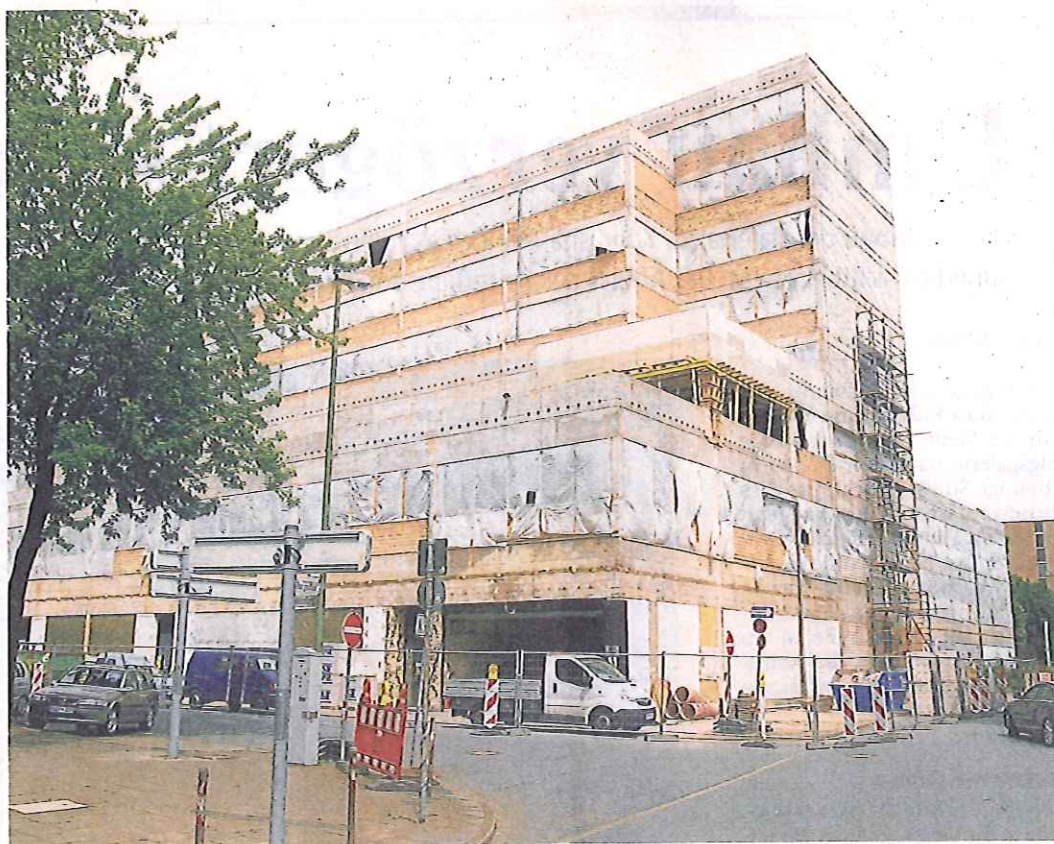
Bis Juni 2011 werden die Arbeiten am Sparkassengebäude am Kuhlenwall noch dauern. Dann könnte auch das geplante Café im Erdgeschoss eröffnen.
