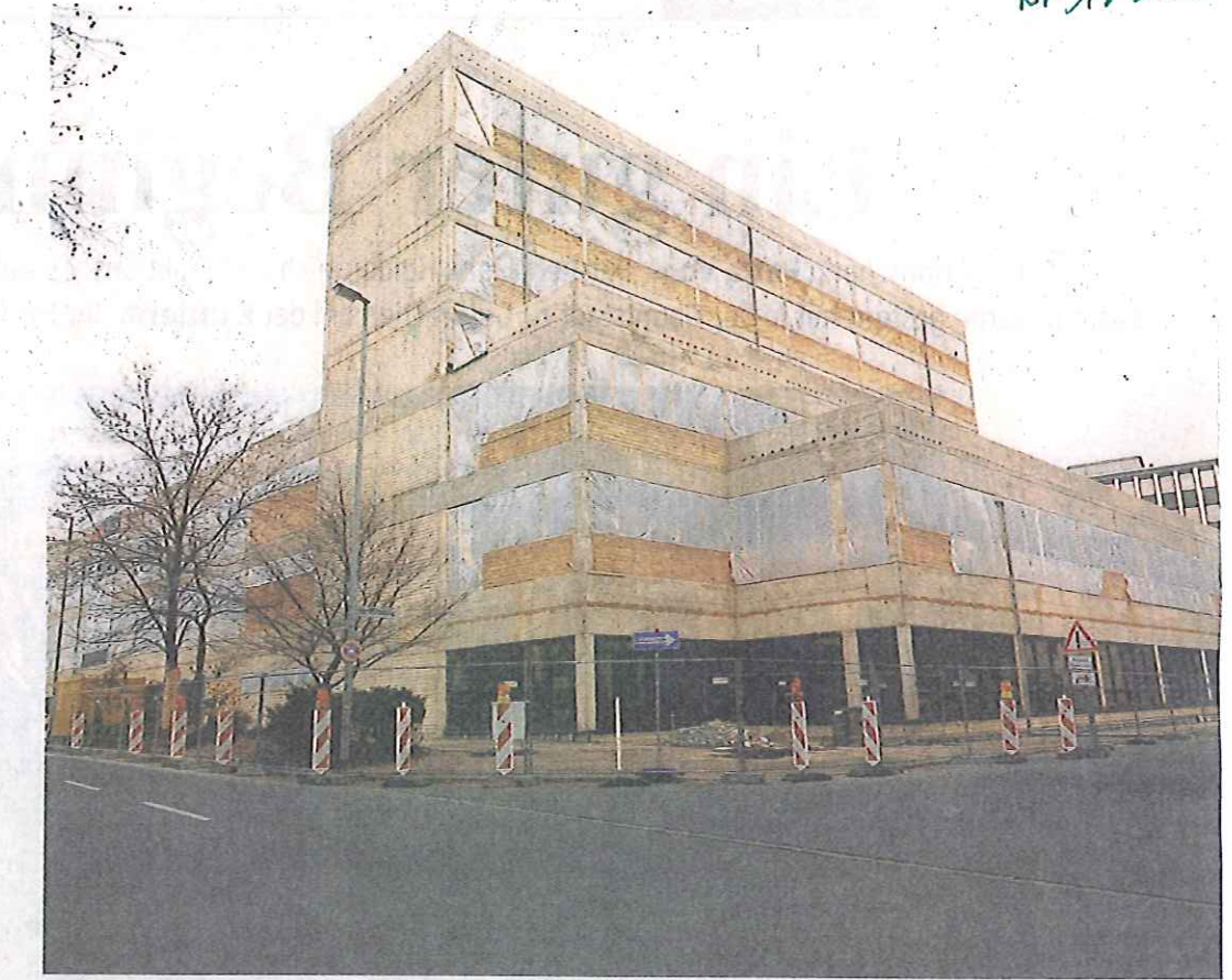
Für die vollständige Sanierung des Sparkassen-Gebäudes war auch ein der Abriss der Fassadenverkleidung notwendig. Ein Teil des Gebäudes soll anschließend frei vermietet werden.
