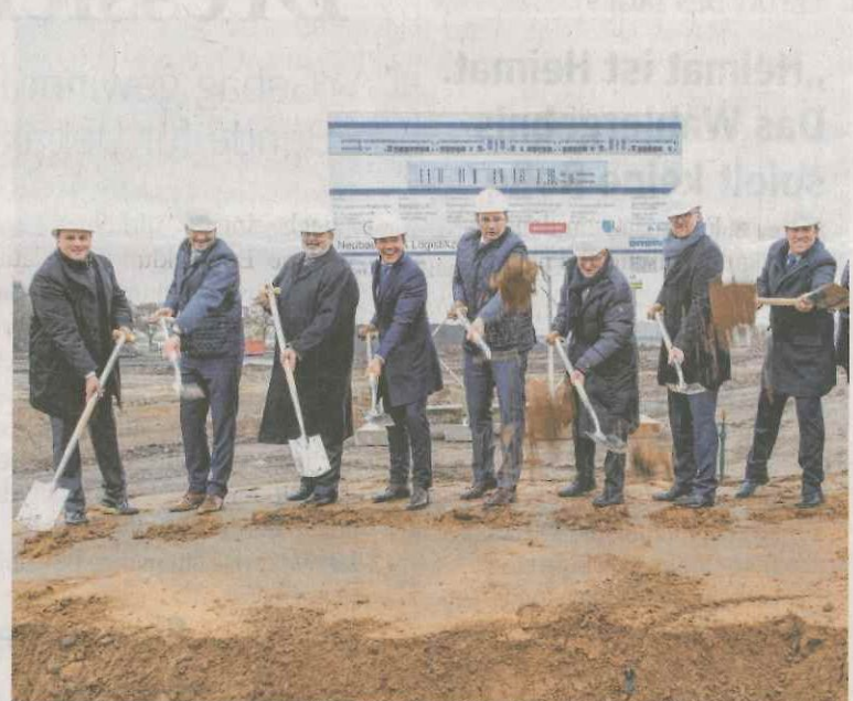
Spatenstich im neuen Gewerbepark Duisburg: v.l. Ulrich Wörner (Alpha), Markus Dörgerloh, Michael Wortmann (VCK), Thomas Hagedorn, Dirk Völker, Manfred Stüdemann, OB Sören Link, Planungsdezernent Carsten Tum.
