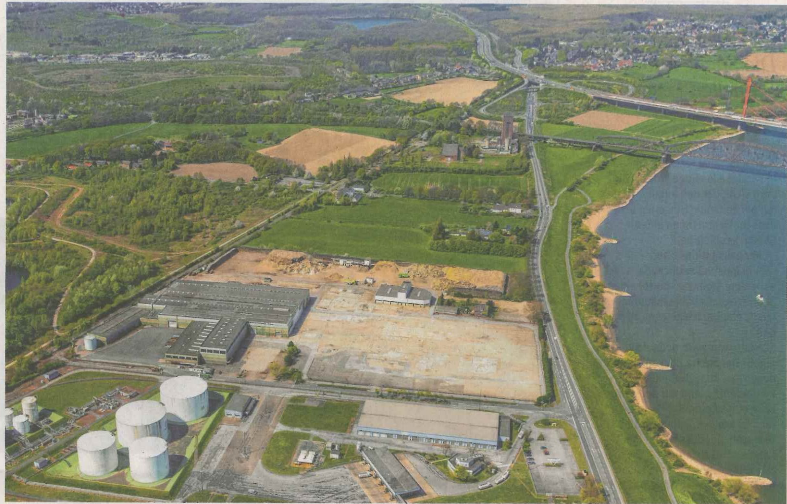
Blick auf das ehemalige Hornitex-Gelände oberhalb des Benzinlagers. Mittlerweile ist das Gelände komplett freigeräumt.
